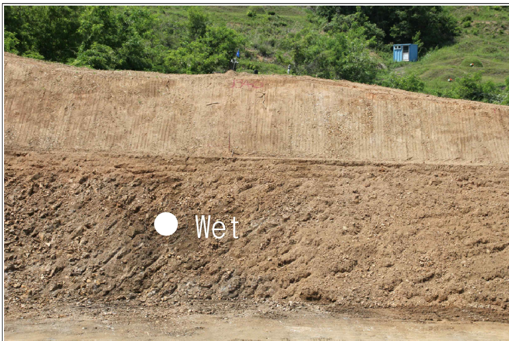
【그림 22】 B 영역 상세사진 (지하수 유출)
