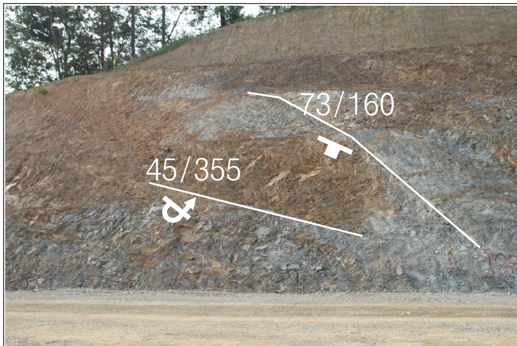
【그림 11】 A 영역에 발달한 불연속면
