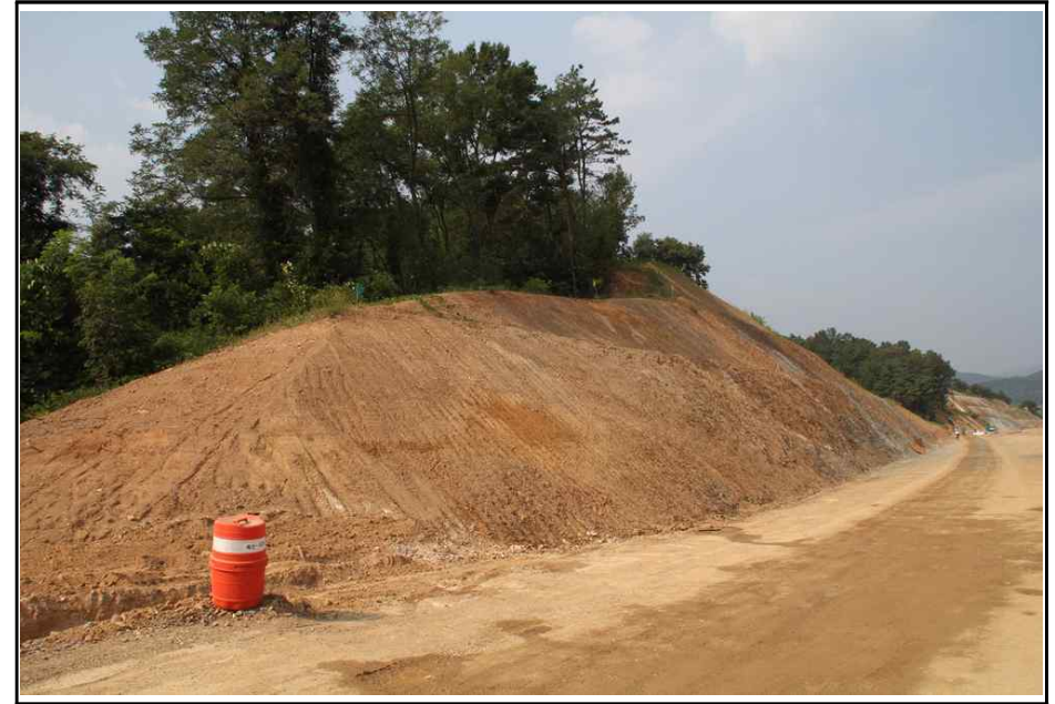
【그림 4】 깎기비탈면 종점부 측면 사진
