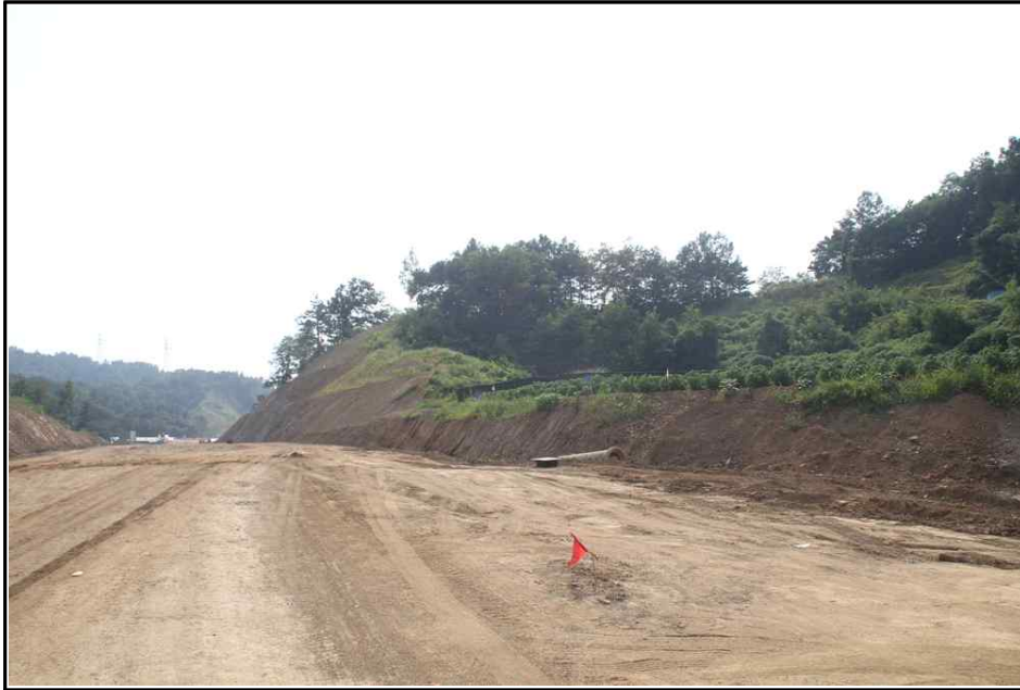
【그림 3】 깎기비탈면 시점부 측면 사진
