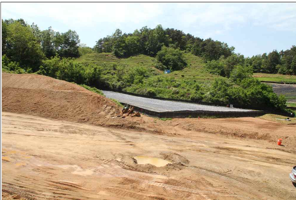
【그림 6】 상부 농작물 재배 구간 (STA.9+340~9+380)
