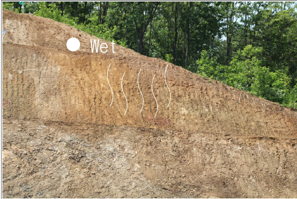
【그림 21】 B 영역 상세사진 (지하수 유출 및 토사유실)
