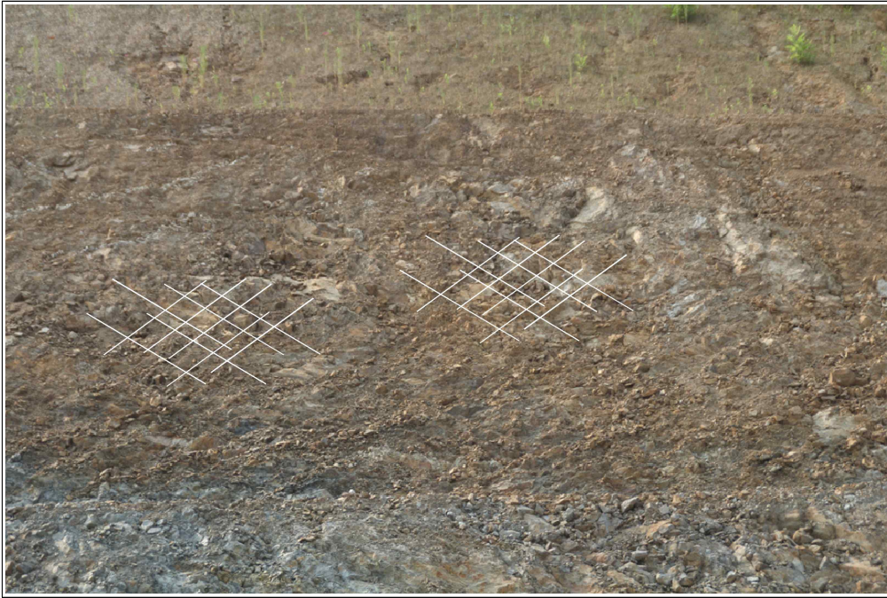
【그림 16】 A 영역 상세사진 (세편화된 암석)
