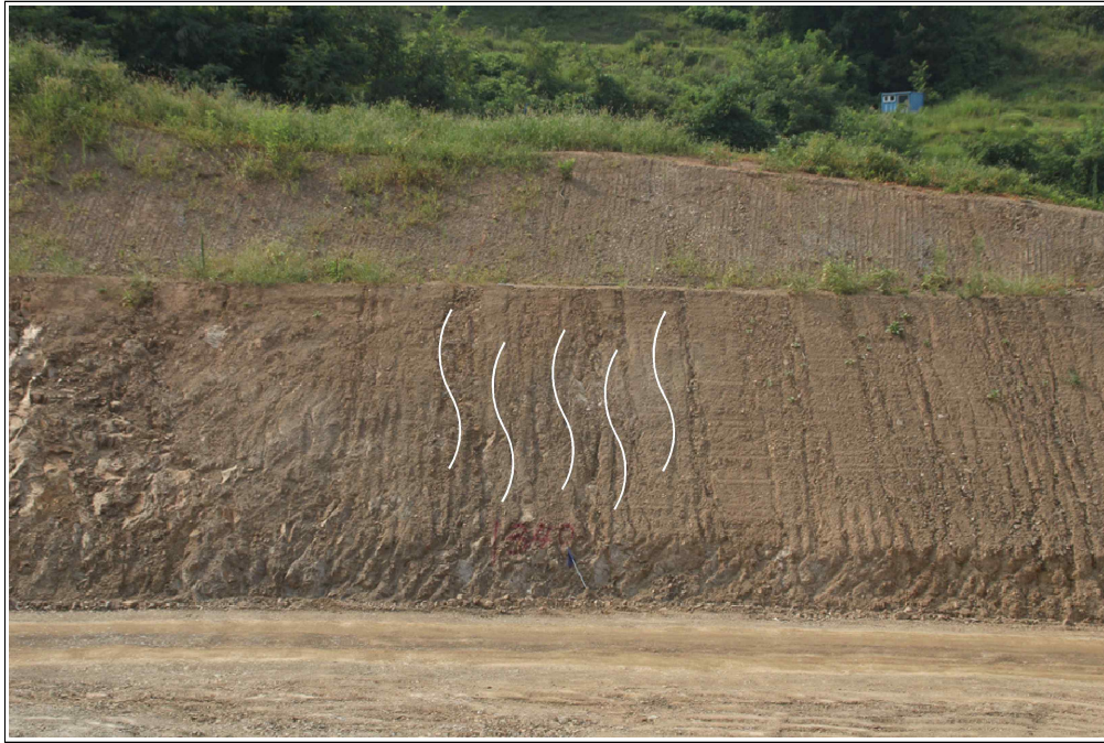
【그림 23】 B 영역 상세사진 (토사유실)
