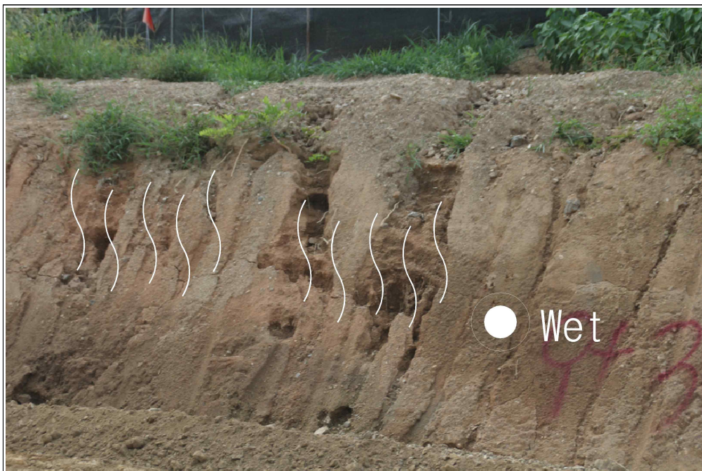
【그림 20】 B 영역 상세사진 (지하수 유출 및 토사유실)
